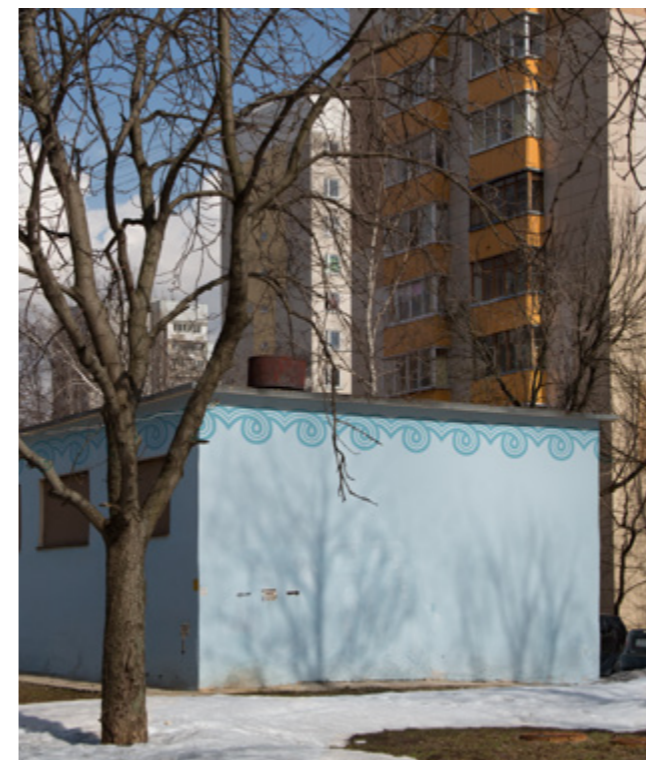
Узор на трансформаторной будке Pattern on a transformer building
