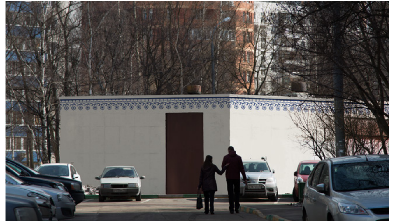
Узор на трансформаторной будке Pattern on a transformer building
