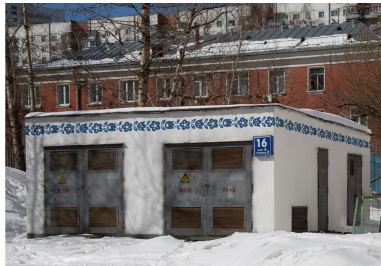
Узор на трансформаторной будке Pattern on a transformer building
